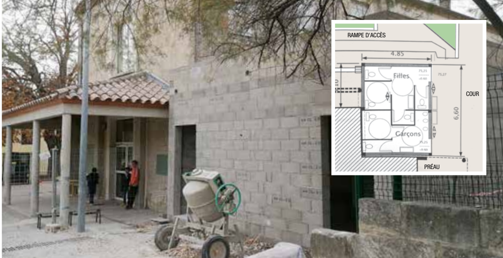
Bloc sanitaire en construction à l'école élémentaire
