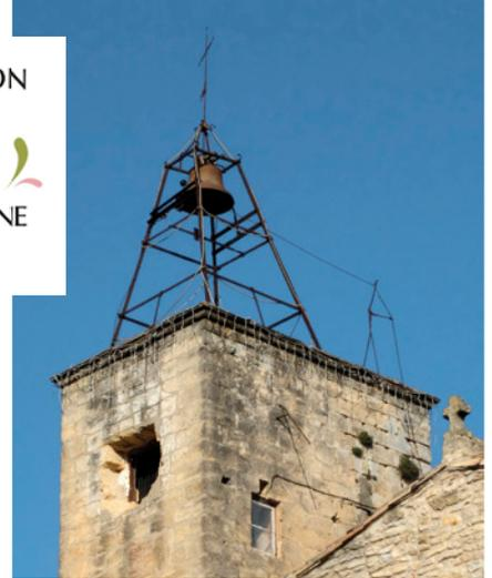
Les travaux envisagés consistent à la restauration du cadran initial en pierre de l'horloge en façade ouest, à la reprise de l'étanchéité de la plateforme, à la mise en place d'un paratonnerre, en la restitution du cadran solaire en façade sud. Les façades nécessiteront un rejointement partiel, le campanile ayant subi des déformations de structure sera redressé et triangulé afin de retrouver ses dispositions d'origine.
