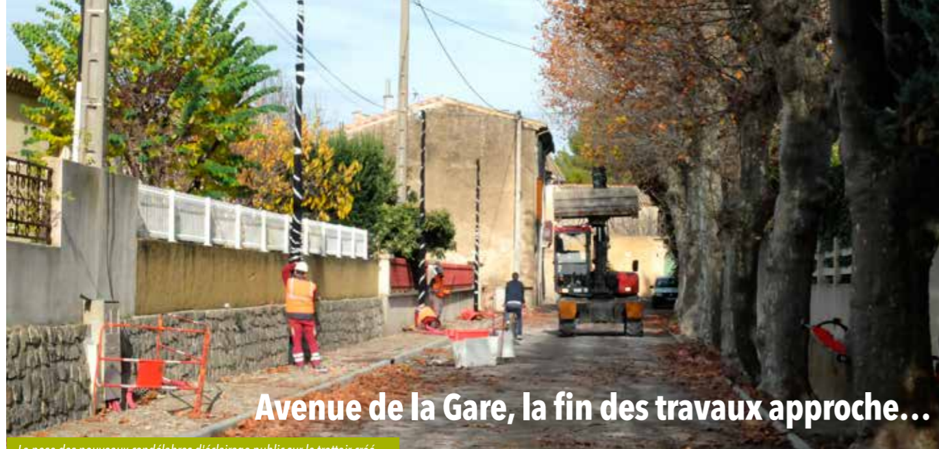
La pose des nouveaux candélabres d'éclairage public sur le trottoir créé.
