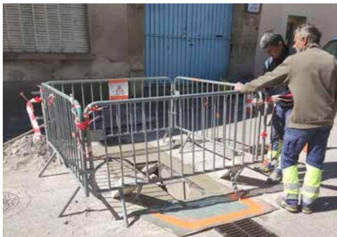
La grille de type "avaloir" qui réceptionne les eaux pluviales sur la route au niveau des N°10/12 de l'avenue des Quakers s'est dégradée et rendait la circulation dangereuse. Nos agents ont effectué des travaux de sécurisation. Ceux-ci ont également permis de réduire certaines nuisances sonores provoquées par le passage des véhicules sur les plaques d'égouts situées à proximité.
